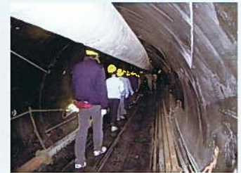
トンネル坑内を見学
