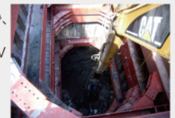
立坑施工状況
