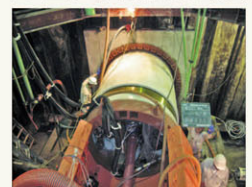
仮掘進施工中
