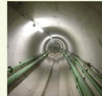
トンネル坑内
