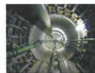
坑内急曲線部 R=20mの出口
