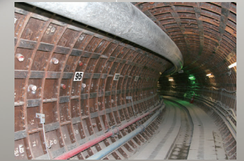
急曲線部施工
