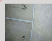
セグメント組立後の状況
