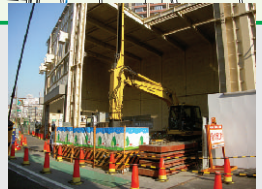
発進立坑掘削状況
