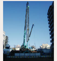
発進立坑施工状況
