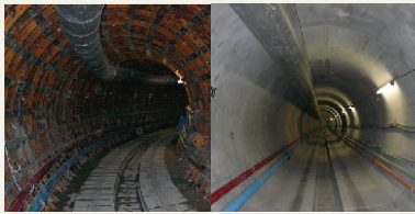
R=16m急曲線部
