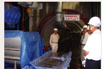
現場風景(発進立坑下)
