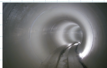
急曲線二次覆工状況
