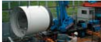
シールド機投入状況
