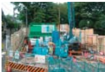
発進基地地盤改良状況
